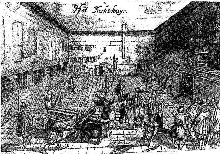
2. Binnenplaats van het Amsterdamse Rasphuis
